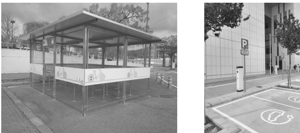
Figura 39: Nuevos aparcamientos cerrados para bicicletas (izquierda) y puntos de recarga de vehículos eléctrico (derecha). Los aparcamientos de bicicletas disponen de alimentación eléctrica para la carga de baterías de vehículos de movilidad personal.
