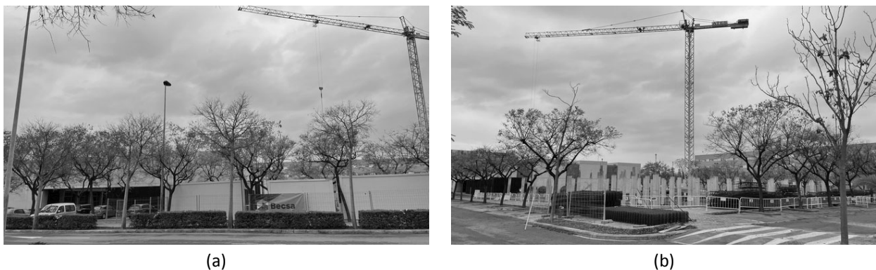
Figura 46: Obras de construcción del nuevo edificio de investigación. (a) Edificio de investigación 1, con el que se integra el nuevo como ampliación. (b) Estado de las obras en marzo de 2022.
