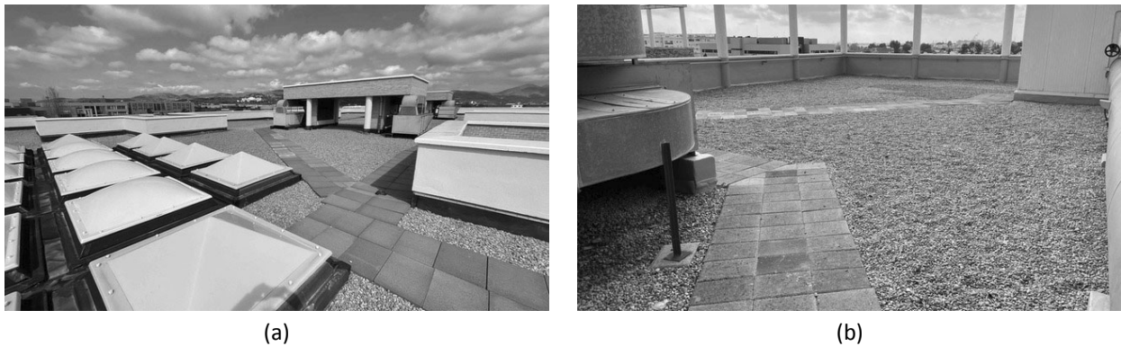
Figura 41: (a) y (b) Reparación y mejora del aislamiento del techo de la Escuela Superior de Tecnología y Ciencias Experimentales.
